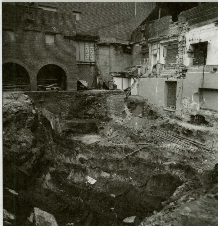
Строительство нового здания Театра на Таганке
